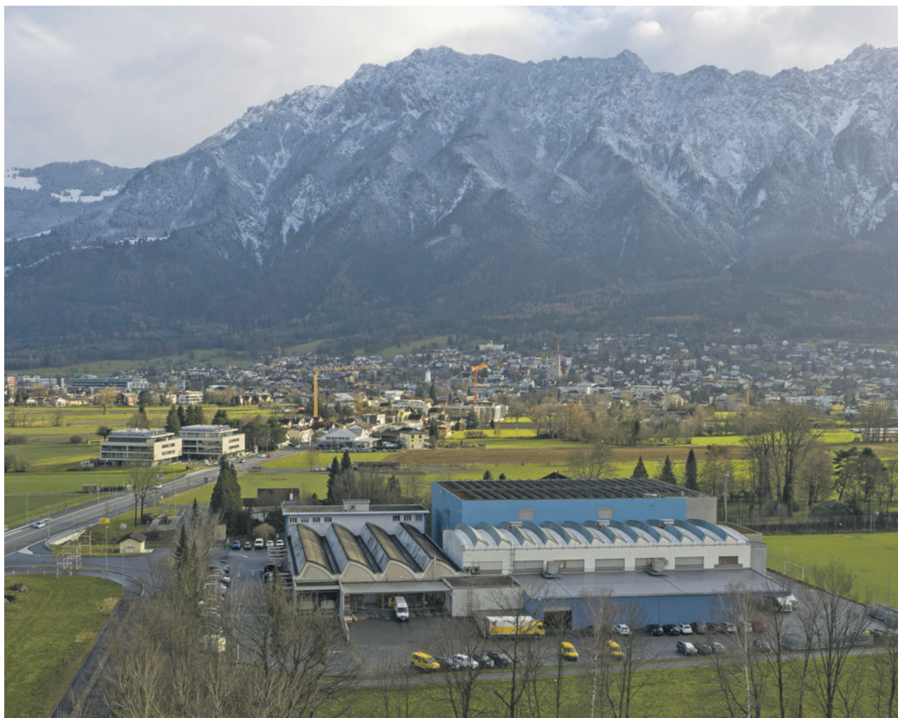
Das Verteilerzentrum der Liechtensteinischen Post AG in Schaan von oben. (Foto: Michael Zanghellini)
