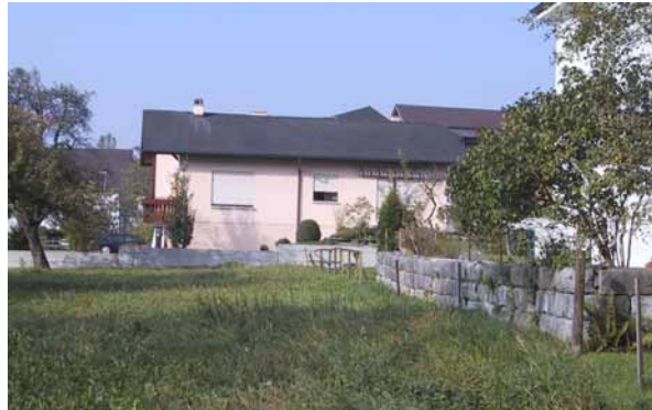
Unnötige Aufschüttung um Gebäude
