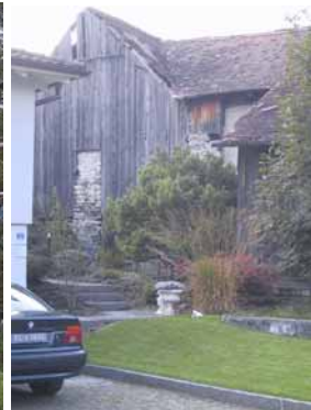
Ein sensibler Umgang mit dem Alten soll gefördert werden.
