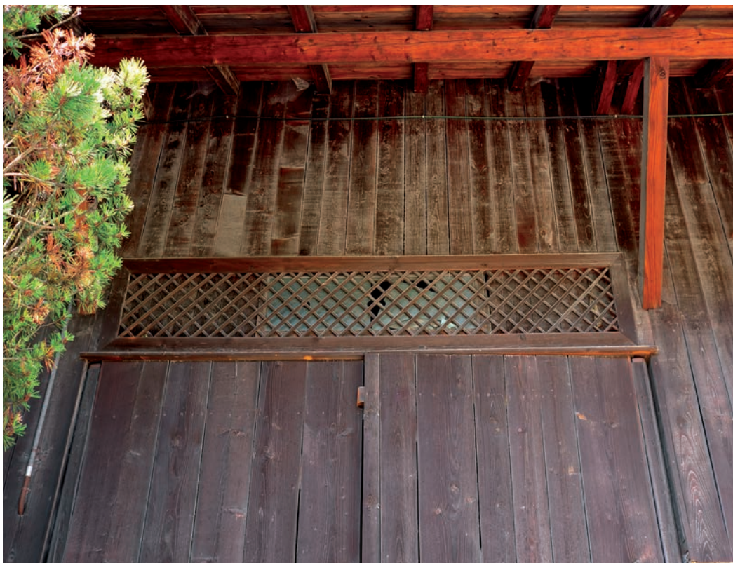
Abb. 7: Stallscheune aus dem Jahr 1951. Tenntor mit hölzernem Lüftungsgitter.
