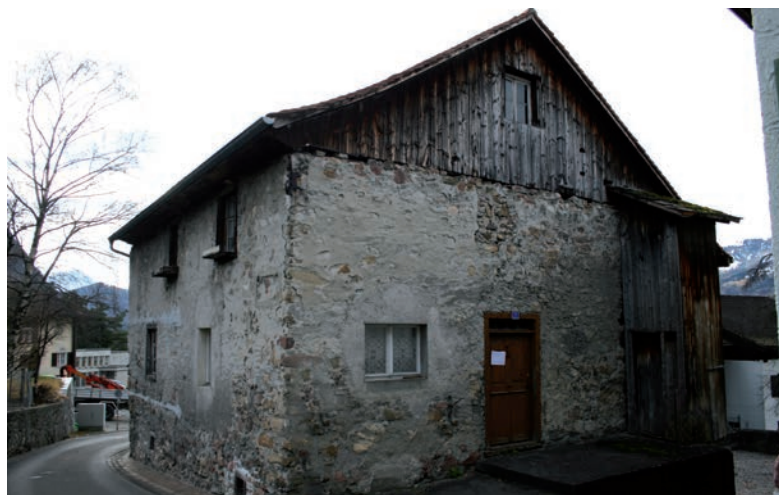
Abb. 2: Nordostansicht des Wohnhauses.
