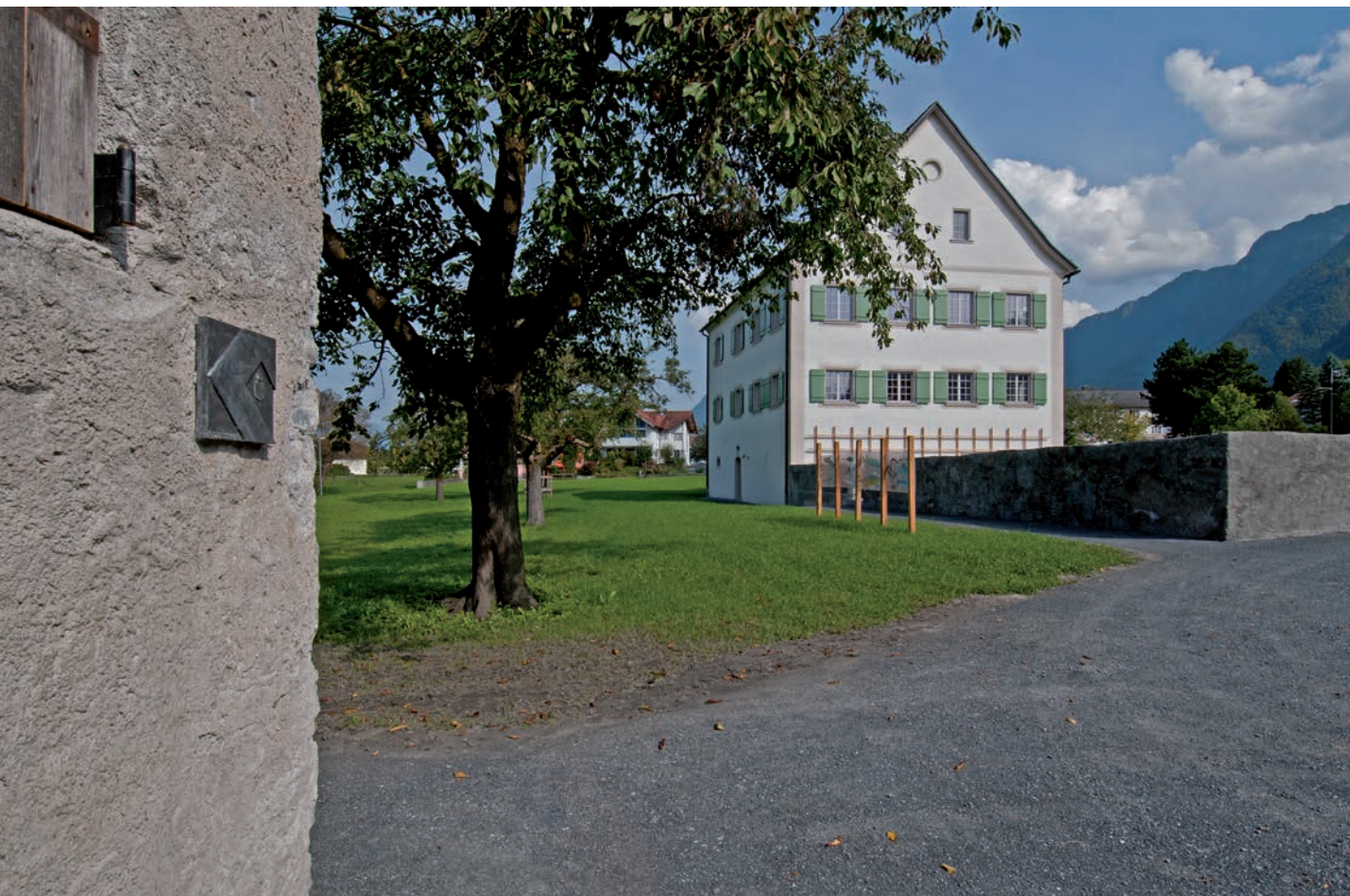
Abb. 1: Balzers, Alter Pfarrhof und Pfarrstall. Seit der Restaurierung 2011 Kulturzentrum der Gemeinde.
