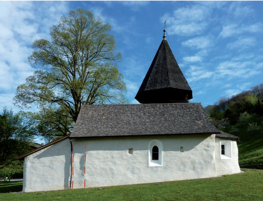
Abb. 28: Triesen, Kapelle St. Mamertus. An der Südwestecke des Laienschiffs als Unregelmässigkeiten in der Verputzoberfläche ablesbare Spuren des nicht mehr vorhandenen Anbaus.
