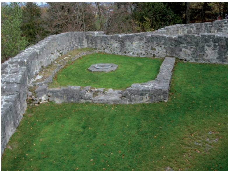
Abb. 35: Filterzisterne mit rundem Schöpfschacht.
