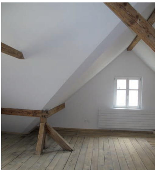
Abb. 6: Das ausgebaute Dachgeschoss bietet weiteren attraktiven Wohnraum.
