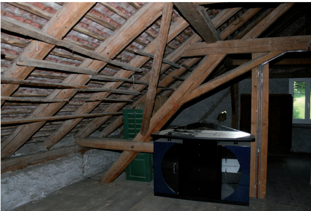
Abb. 3: Wohnhaus. Dachstuhl von 1905 mit Freibinder liegender Art und Kniestockauflager. Am Rafeinwerk Lattung zum Trocknen von Maiskolben.
