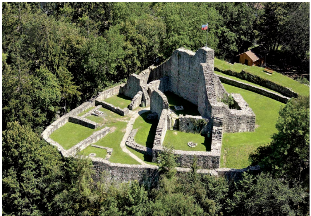
Abb. 31: Schellenberg, Obere Burg. Flugaufnahme von Nordwesten.
