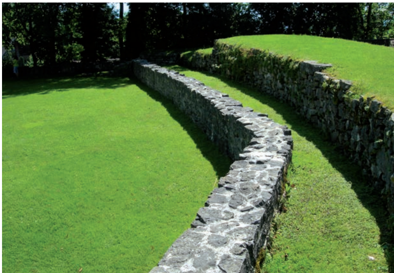
Abb. 39: Schellenberg, Obere Burg. Breiter Burggraben mit Trockenmauer.
