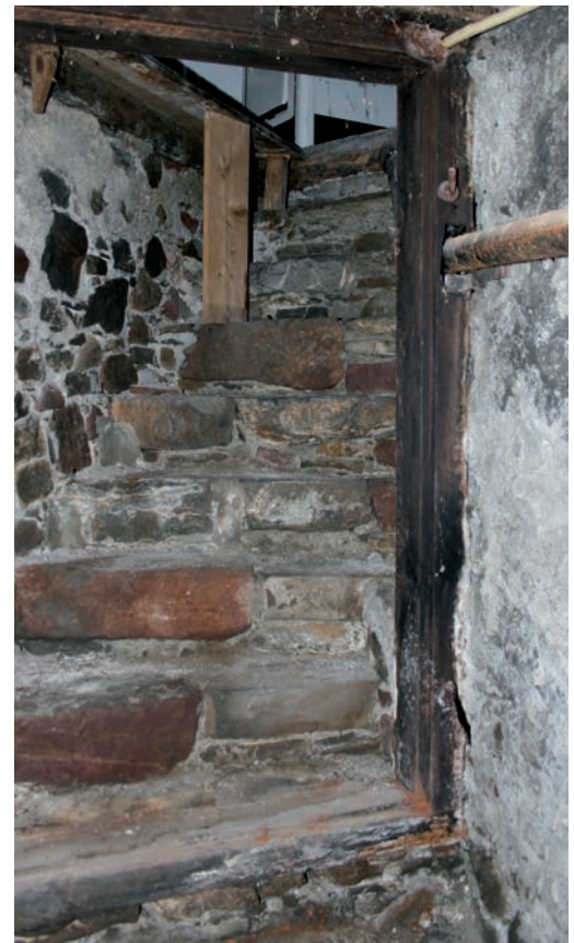
Abb. 6: Wohnhaus. Keller von 1846 mit Aufgang in die Küche.
