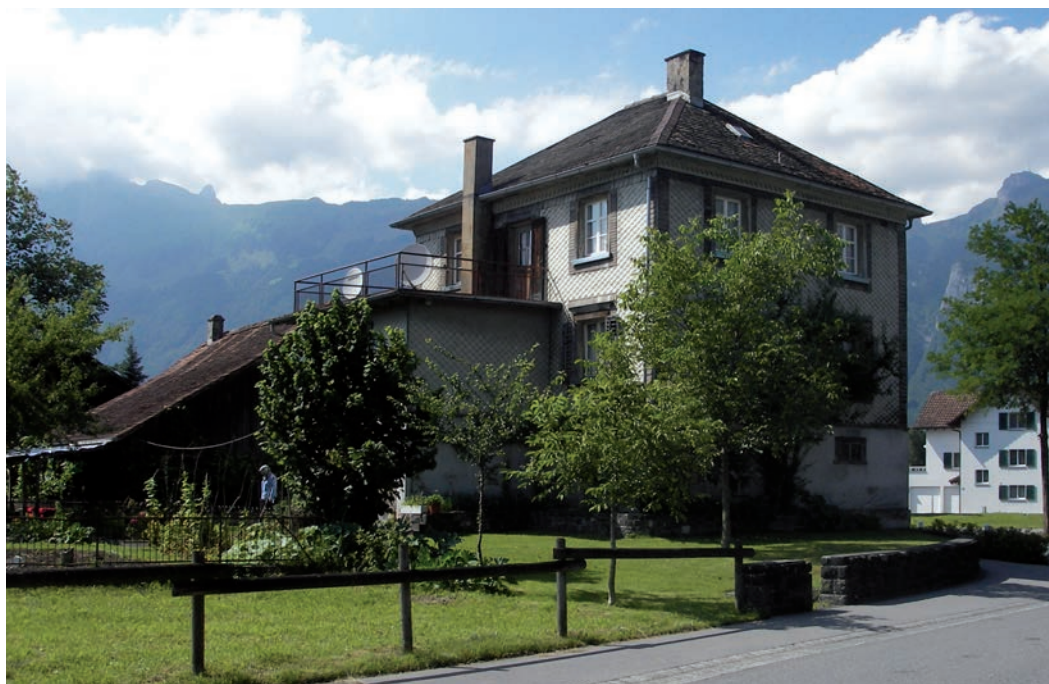
Abb. 5: Südseitiger Anbau von 1949 mit Waschküche im Erdgeschoss und Studierzimmer des Pfarrers im Obergeschoss.
