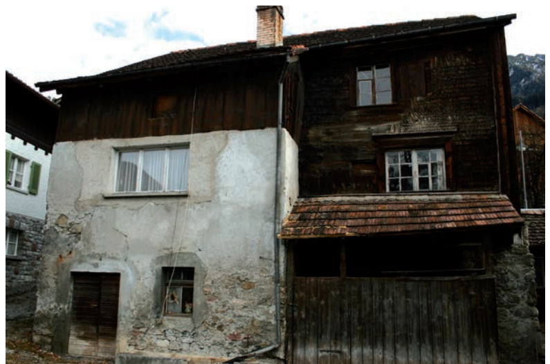
Abb. 3: Westfassade der Hofstätte.
