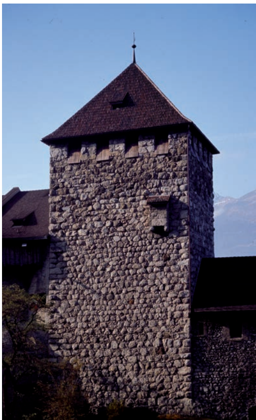
Abb. 63: Aktuelles Erscheinungsbild. Ostfassade des Bergfrieds im Sommer 2008.
