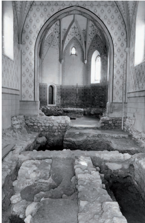
Abb. 14: Schaan, Kapelle St. Peter. Blick auf die freigelegte Taufanlage während der Ausgrabung 1958.
