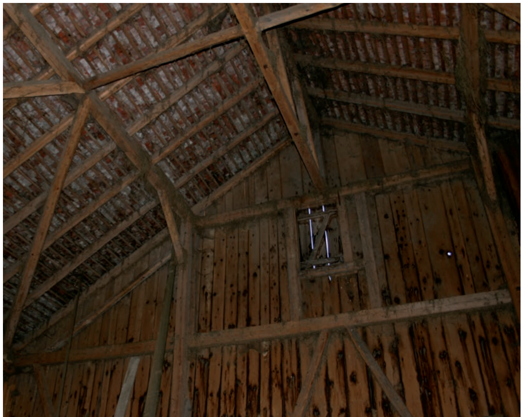
Abb. 6: Stallscheune. Fachwerkabzimmerung von 1951.
