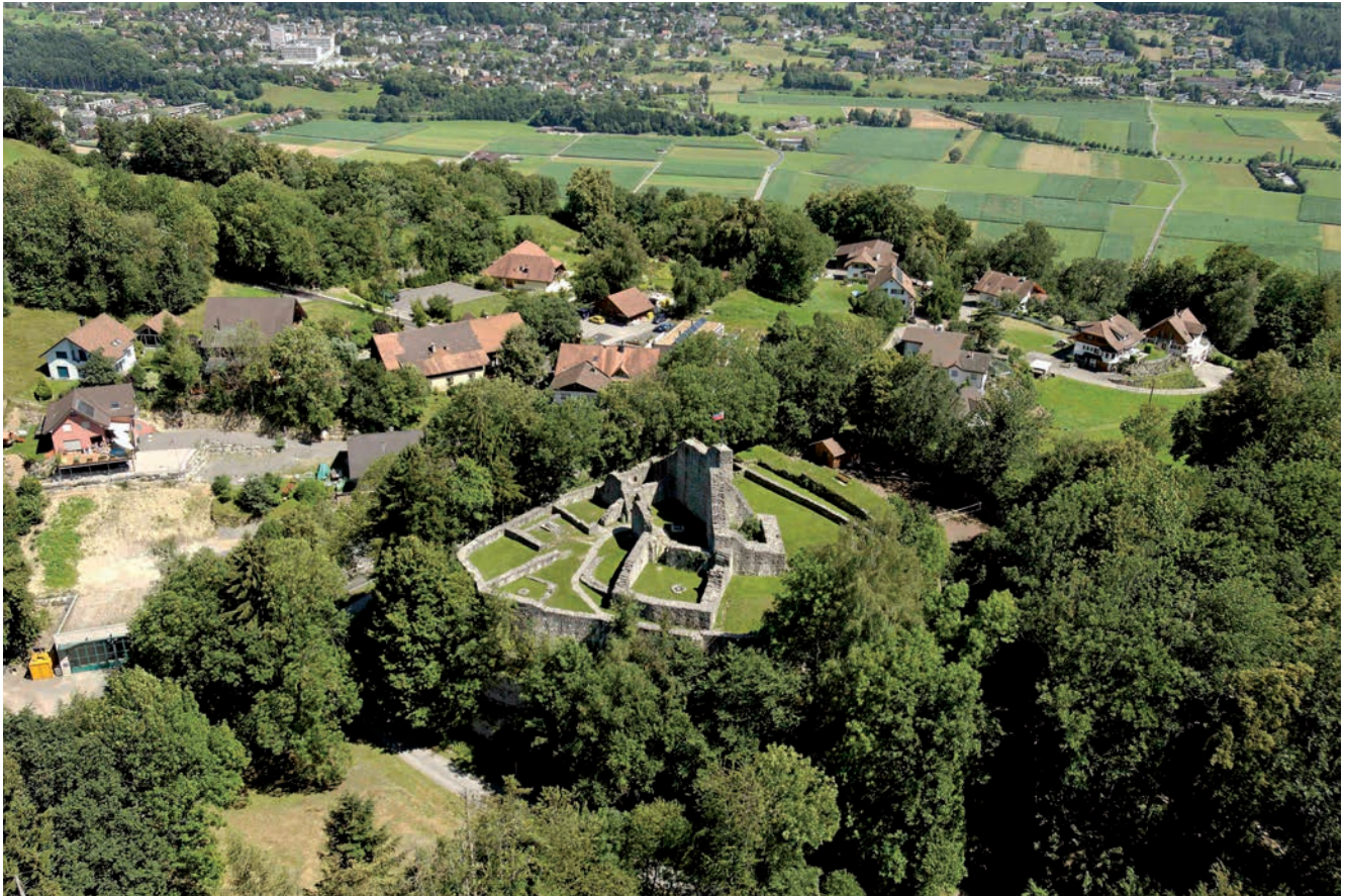
Abb. 30: Schellenberg, Obere Burg. Flugaufnahme von Nordwesten.
