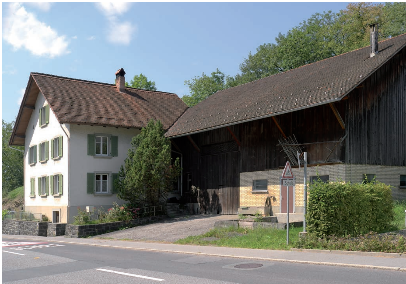
Abb. 1: Gamprin, Bühl 33. Ostansicht der Hofstätte mit dem Wohnhaus von 1905 und der Stallscheune von 1951.
