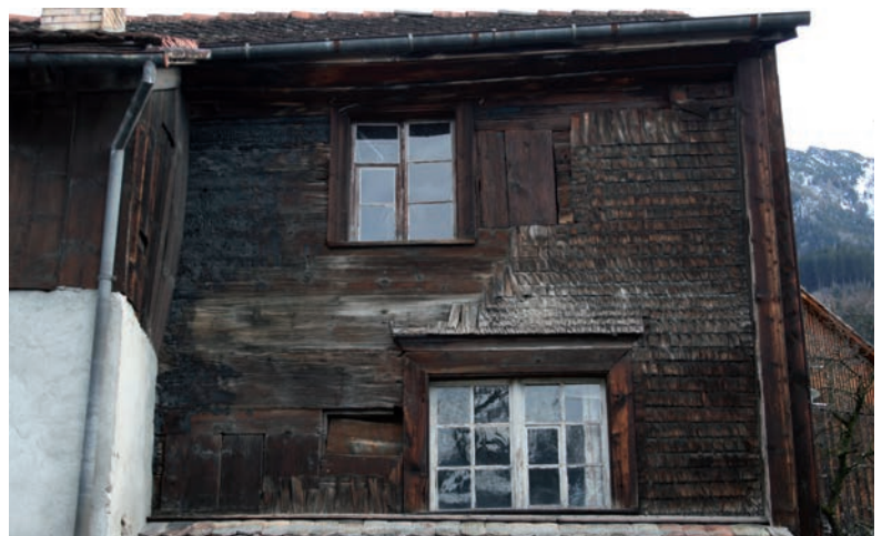
Abb. 4: Westfassade. Blockbau von 1454 mit Schindelschirm aus der Zeit um 1755. Oben links Brandschaden von 1870. Links des Stubenfensters und rechts des Kammerfensters befinden sich verschlossene, ältere Fensteröffnungen.
