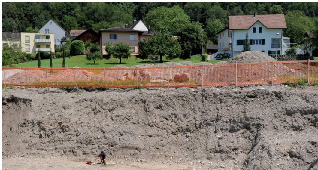
Abb. 10: Die Baugrube, auf deren Sohle die Doppelbestattung zum Vorschein kam.
