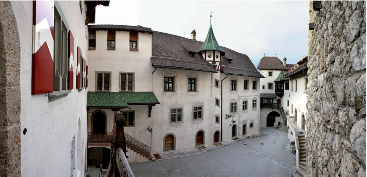
Abb. 68: Schloss Vaduz. Innenhof mit Blick gegen den Westtrakt nach Abschluss der Sanierungskampagne.
