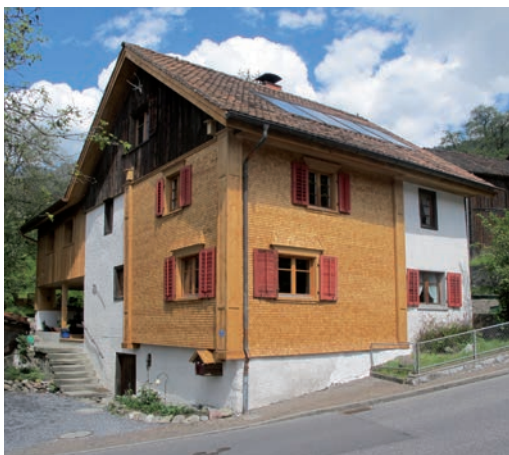
Abb. 4: Wohnhaus mit neuer Schindelfassade und rückwärtigem Anbau.
