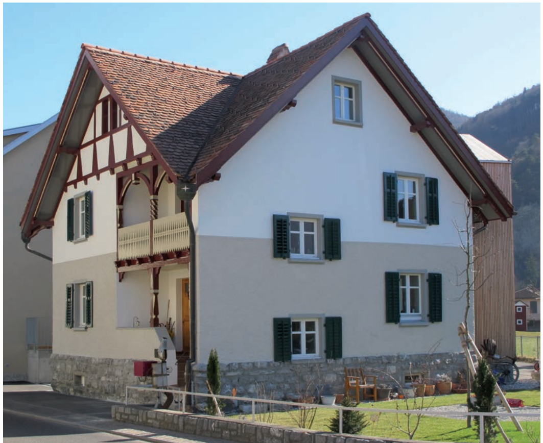
Abb. 2: Das instandgesetzte Gebäude bildet einen besonderen Akzent an der Orts-einfahrt ins Mälsner Dorf.
