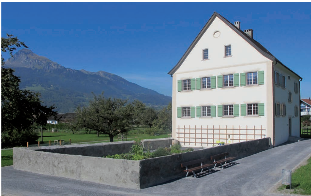
Abb. 1: Balzers, Alter Pfarrhof. Blick auf das restaurierte Hauptgebäude samt Pfarrgarten.
