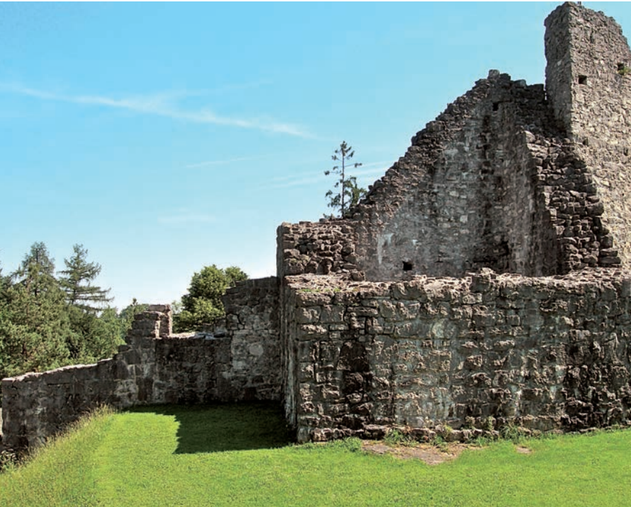
Abb. 34: Schellenberg, Obere Burg. Wohnturm und erstes, nachträglich zugemauertes Eingangstor. Blick von Süden.
