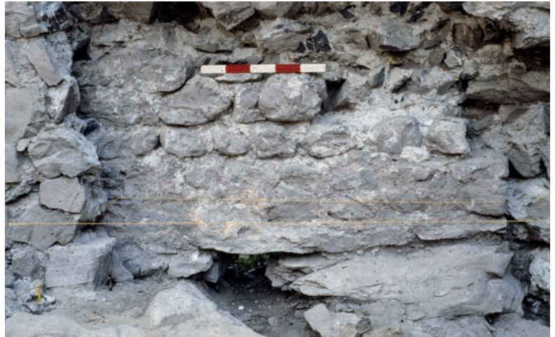
Abb. 9: Balzers, Burg Gutenberg. Auf eisenzeitlicher Trockenmauer aufliegende, römische Mauerecke, die im mittelalterlichen Befestigungswerk erhalten geblieben ist. Blick vom Innenhof auf die Ostwand der Umfassung.
