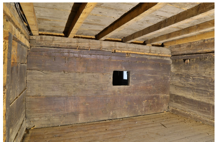
Abb. 3: Grosse Kammer im Obergeschoss, Wände in Blockbauweise, aus 1647, bis 75cm breiten Flecklingen, frühe Fensteröffnung.
