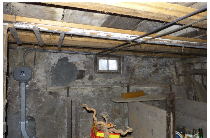
Abb. 6: Keller-Nordwand 1647 mit zugemauerter Öffnung des Bandfensters zum Webkeller.
