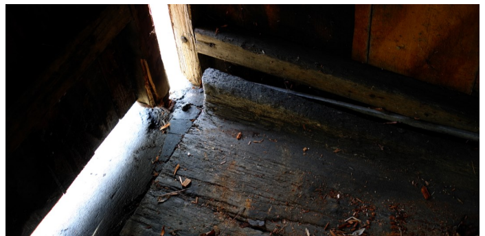
Abb. 8: Tenneboden mit Wulstrand zur Vermeidung von Körnerverlusten beim Dreschen.
