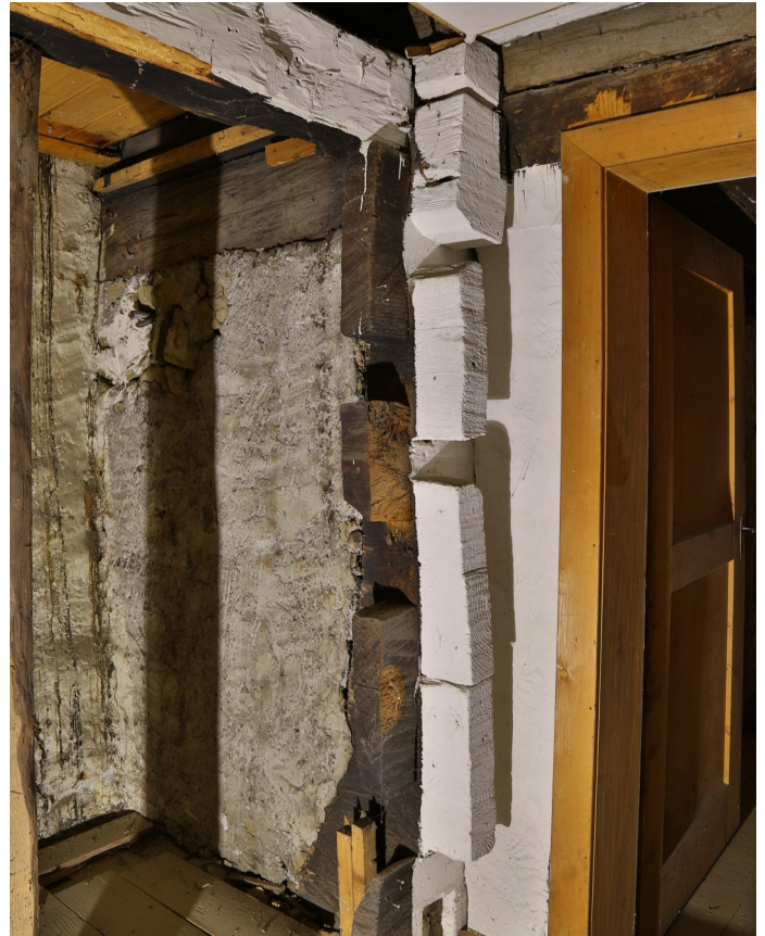
Abb. 4: Obergeschoss, Ecküberkämmung der Flecklinge, 1647.
