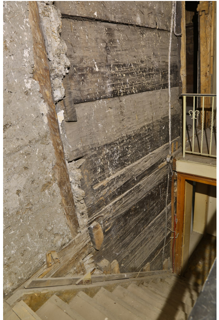
Abb. 5: Nordwand der Küche 1647, ohne Spuren einer Decke.
