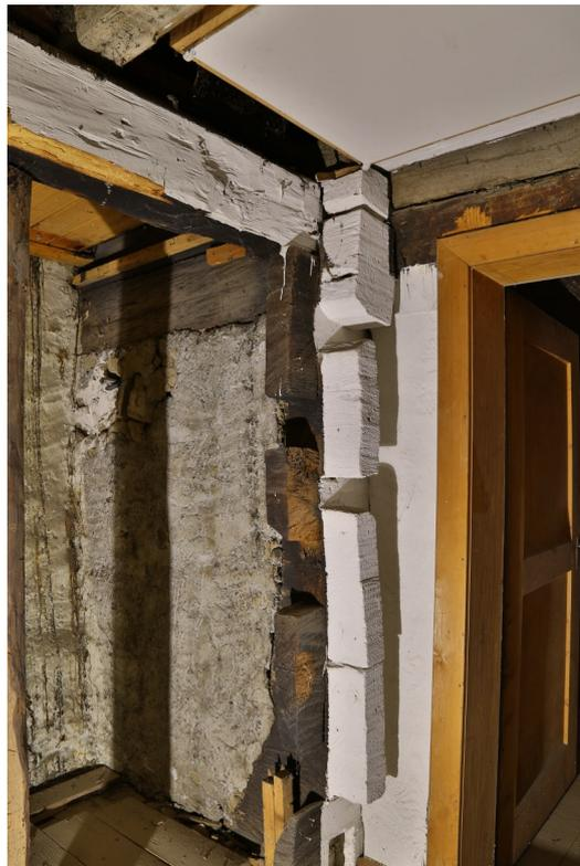
Abb. 4: Obergeschoss, Ecküberkämmung der Flecklinge 1647.
