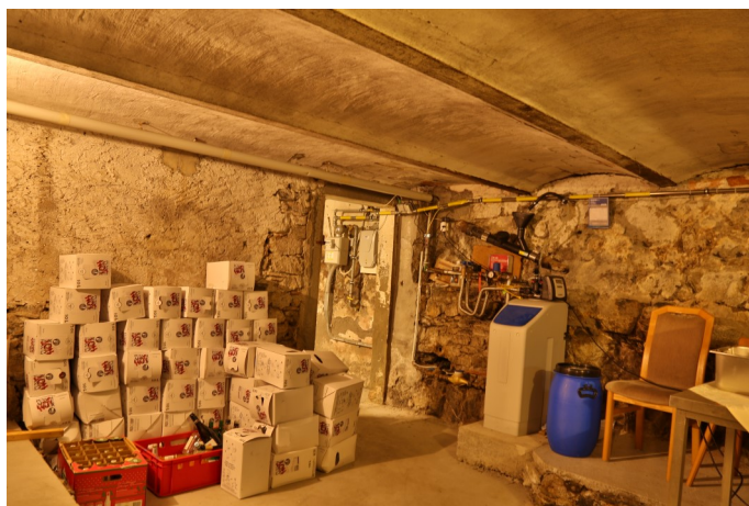
Abb. 3: Hourdis-Decke aus Vollbacksteinen über Stahlträgern.
