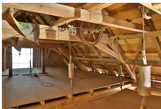
Abb. 4: Fuderaufzug über der Tenne.
