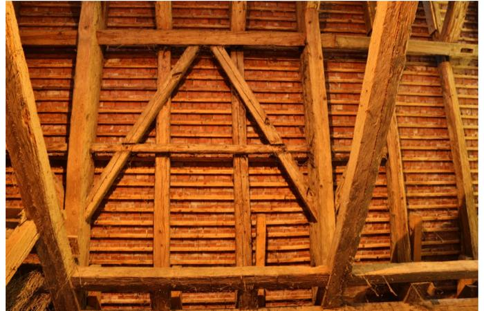
Abb. 2: Dachstuhlabbund von 1842 über der Scheune.
