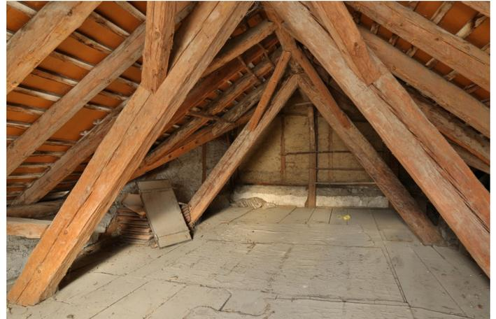
Abb. 2: Der Dachstuhl von 1899 in zeittypischer Abbundmanier.
