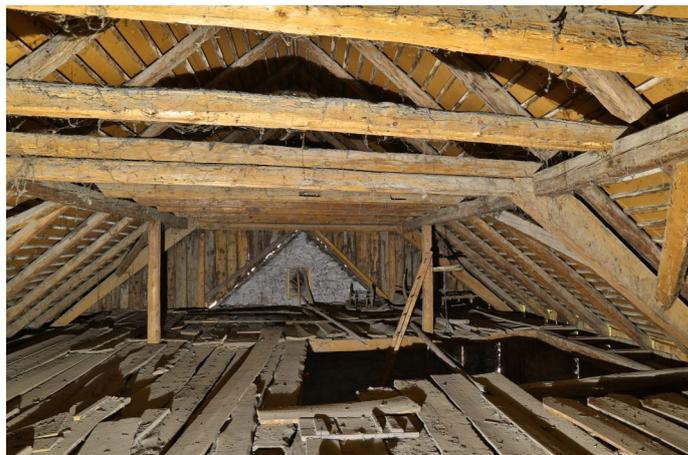
Abb. 8: Mälsner Dorf 34, Einblick in den Dachstuhl von 1873 über der Doppelscheune, hinten die Giebelwand von 1867 mit rhomboider Fensteröffnung des einstigen Torkels.
