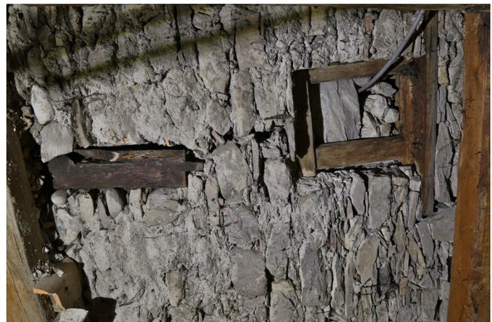
Abb. 6: Mälsner Dorf 34, die westliche Giebelmauer enthält einem Firstständler von 1391, darüber eine zugemauerte Fensteröffnung.
