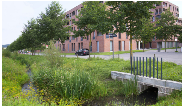
Kaltluftachse entlang Gewässerlauf
