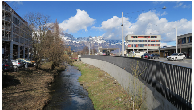
Giessenufer am Bahnhof, Buchs
